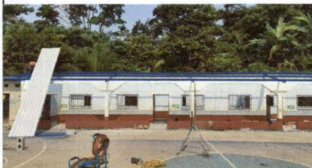
Foto 1: EN PROCESO LA SUSTITUCIÓN DE LÁMINA, POR LÁMINA TROQUELADA ALUZINC
