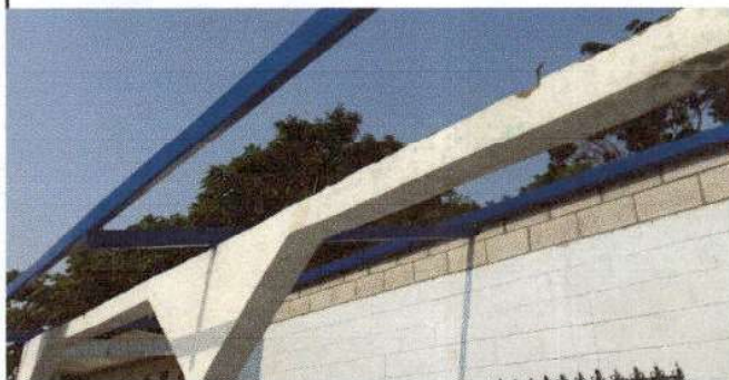
Foto 2: EN PROCESO LA SUSTITUCIÓN DE SOPORTE DE MADERA POR METAL
