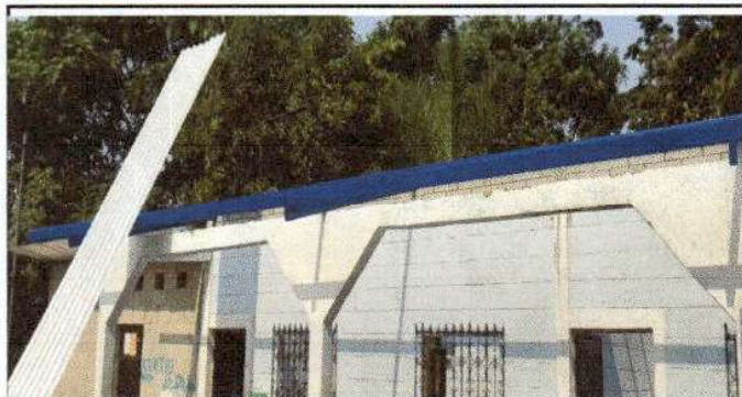
Foto 3: EN CURSO LA SUSTITUCIÓN DE LÁMINA, POR LÁMINA TROQUELADA ALUZINC
