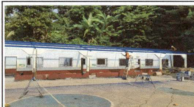
Foto 4: EN MARCHA LA PINTURA DE EXTERIORES E INTERIORES.
